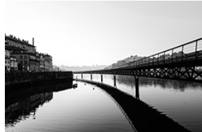
Viaduto do Cais das Pedras
